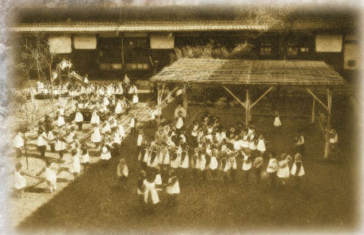
敷津幼稚園が併設されていたころ(昭和5年3月)
